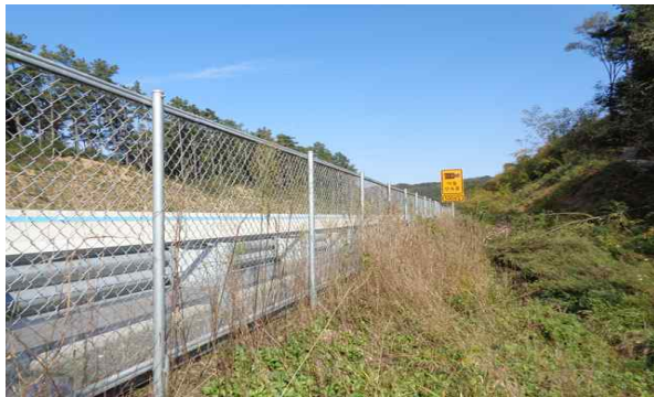
낙석방지 울타리 전경
