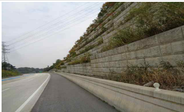
옹벽 구간 전경
