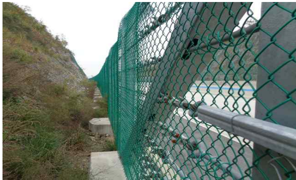
낙석방지 울타리 전경
