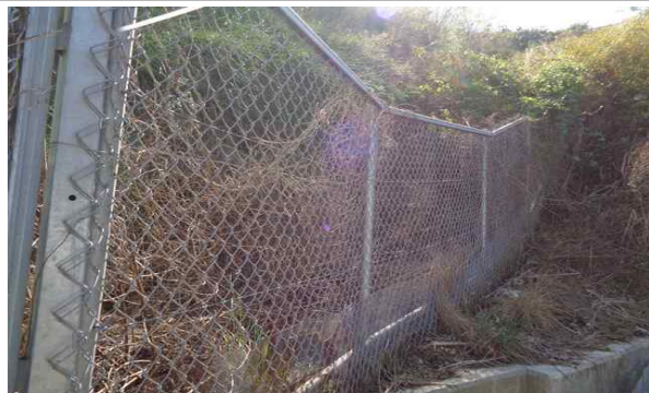
낙석방지 울타리 전경
